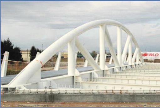
PONTE SU TORRENTE MUSON DEI SASSI – CAMPOSAMPIERO (PD)
