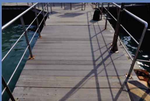
SPERIMENTAZIONE DI TAVOLE IN MATERIALE COMPOSITO (WPC) SU PONTILE ACTV (VE)
