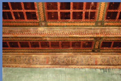
CASTELLO DI BENTIVOGLIO (BO), CASSETTONATO LIGNEO
