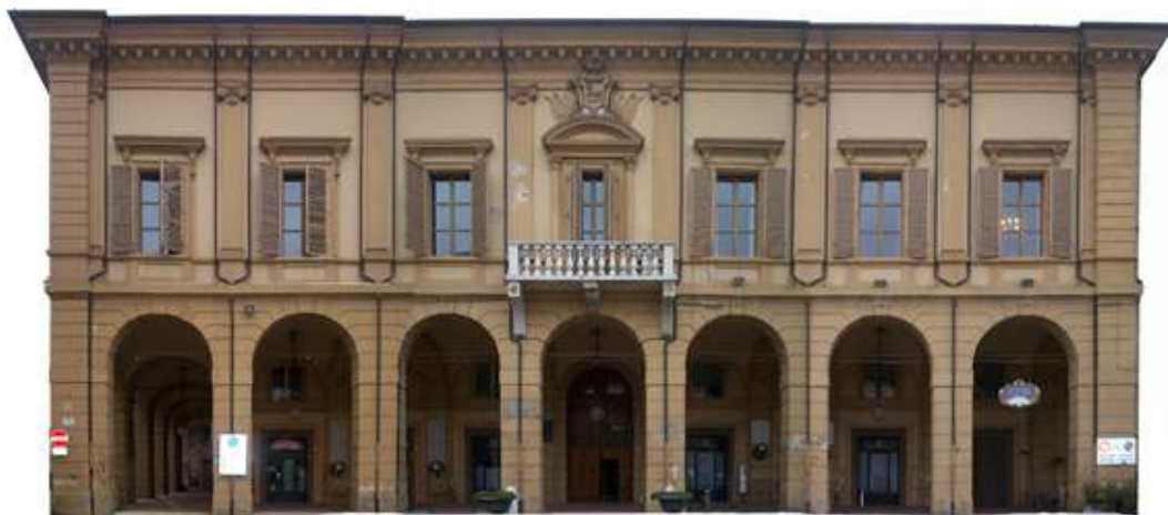
Palazzo Comunale prima dei lavori
