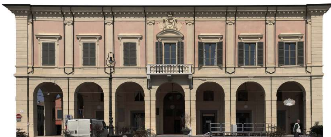
Palazzo Comunale dopo l'intervento
