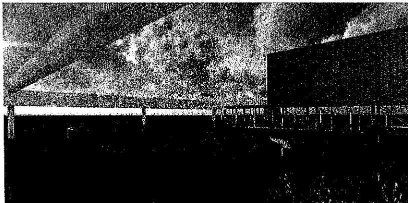
Vista del terrazzo con la veletta di coronamento al cui interno sono collocate le condotte di distribuzione dell'aria trattata. Il parapetto vetrato definisce la forma organica/pozzo di luce
