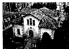
L'immobile prima dell'intervento
