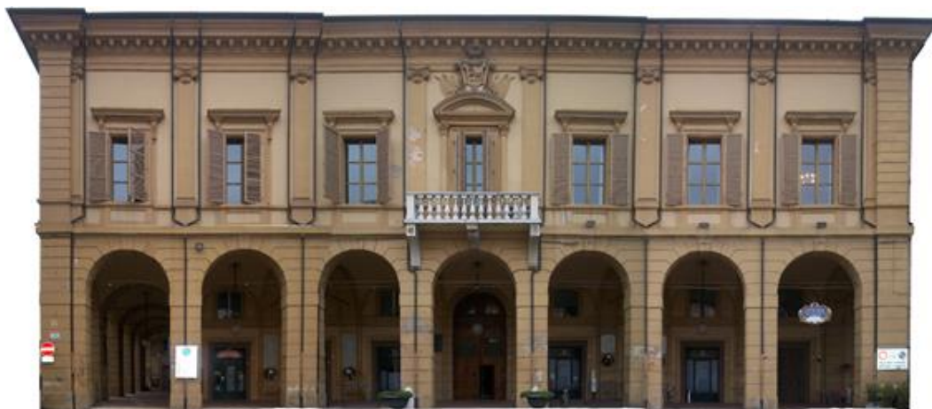
Palazzo Comunale prima dei lavori
