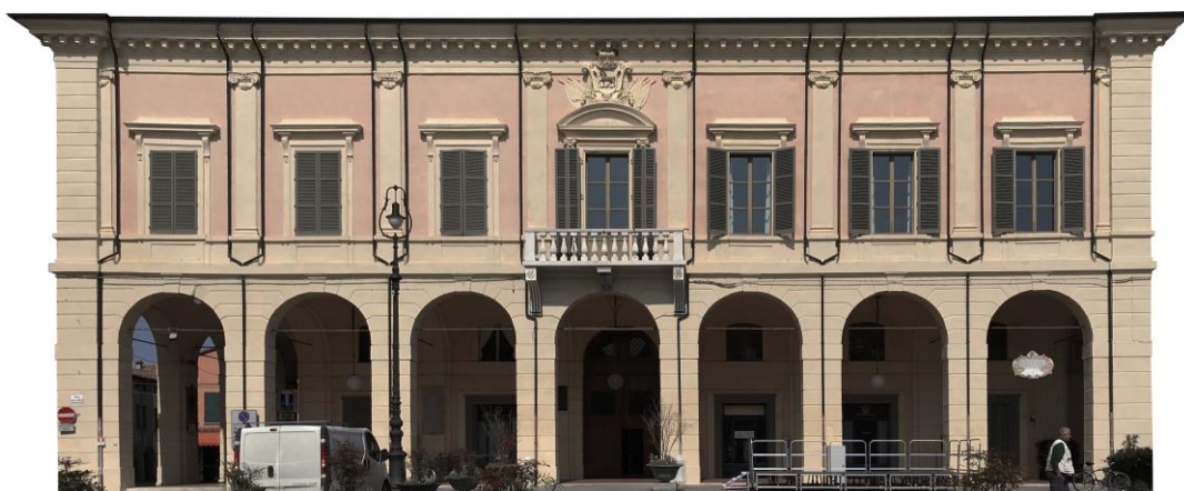
Palazzo Comunale dopo l'intervento
